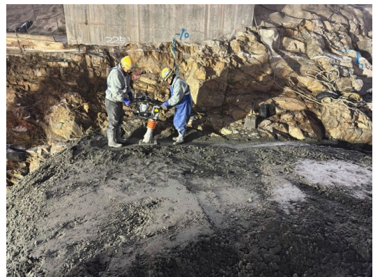
図-13 ランマによる転圧
