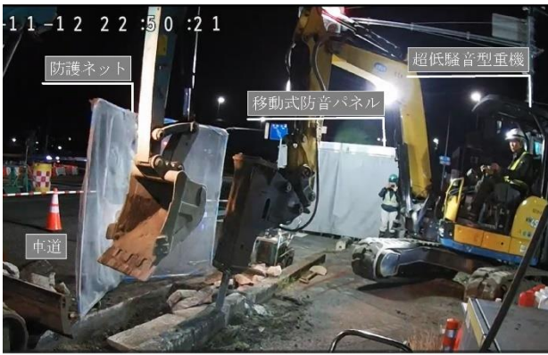
写真-2 夜間工事状況
