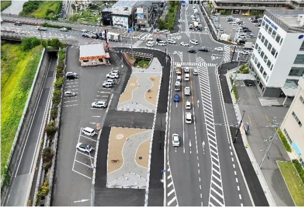
写真-6 事業完了後の状況写真
