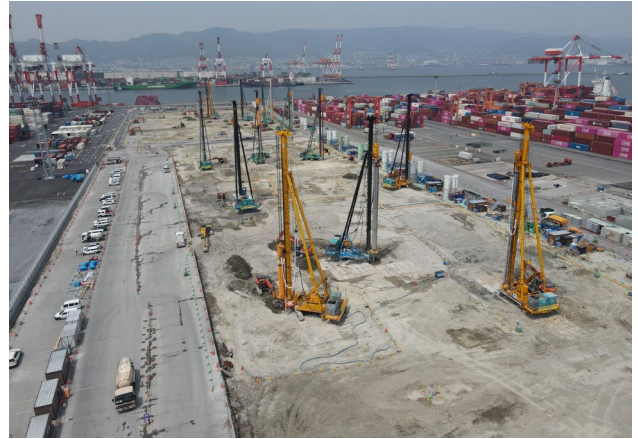
写真-5 場内に分散配置された杭打機
