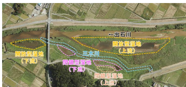
図-2 加陽湿地に整備されている水域
