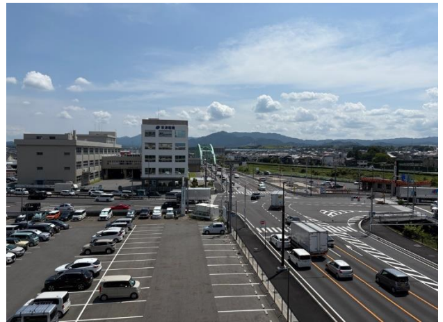
写真-5 事業完了後の状況写真
