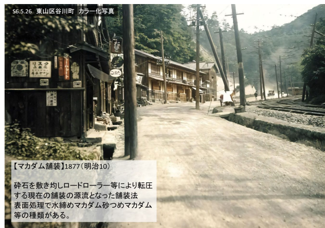
図-15 施工前写真（カラー化処理）マカダム舗装の例
