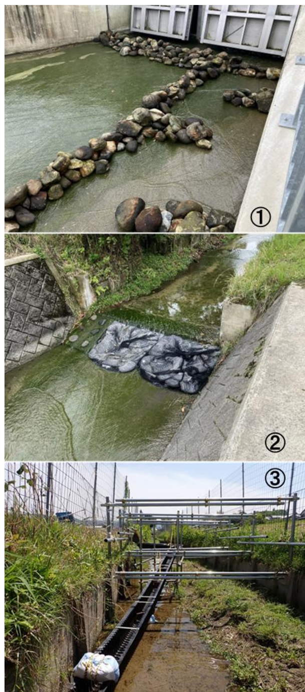
Fig.3 水制工・簡易魚道
