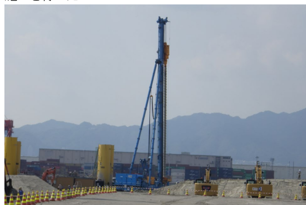
写真-3 機械攪拌による施工
