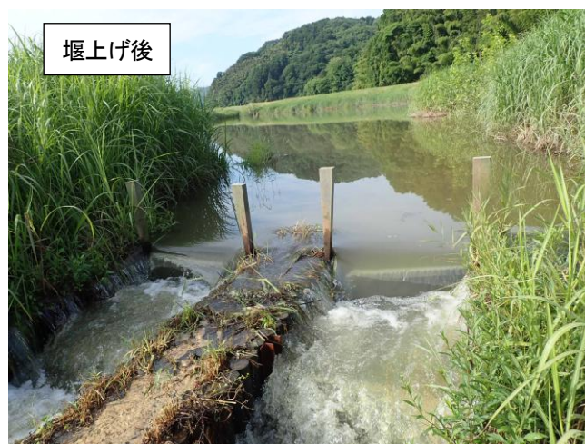
図-3 閉鎖型湿地の堰上げ状況
