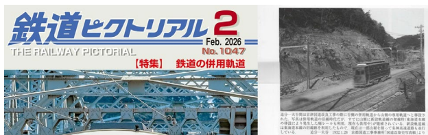
図-19 鉄道ピクトリアル2月号で使用された工事写真
