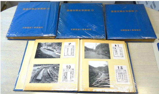
図-1 京都国道工事事務所 国道改築史写真帳（４）～（７）
