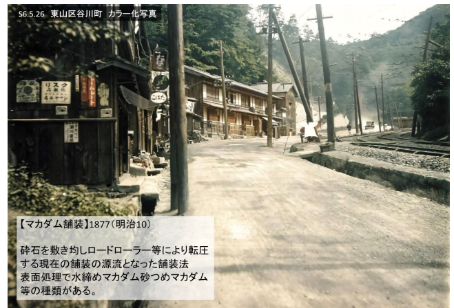
図-15 施工前写真（カラー化処理）マカダム舗装の例
