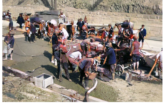
図-13 昭和7年当時の機械化施工の状況（カラー化処理）
