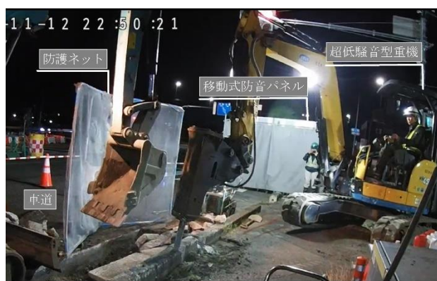
写真-2 夜間工事状況
