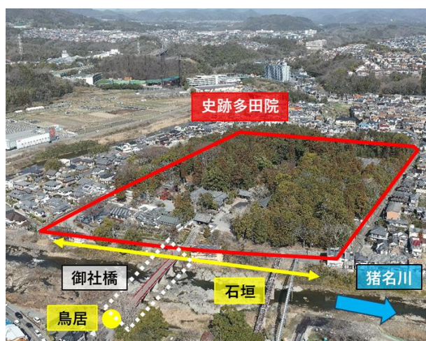
図-2-1 史跡多田院の全景
