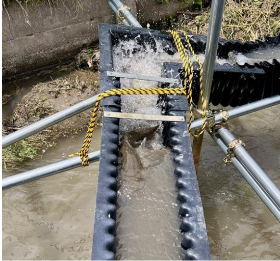
Fig.6 簡易魚道の利用状況
