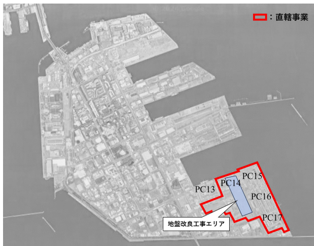
写真-2 施工箇所
