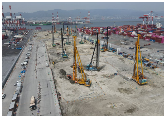
写真-5 場内に分散配置された杭打機
