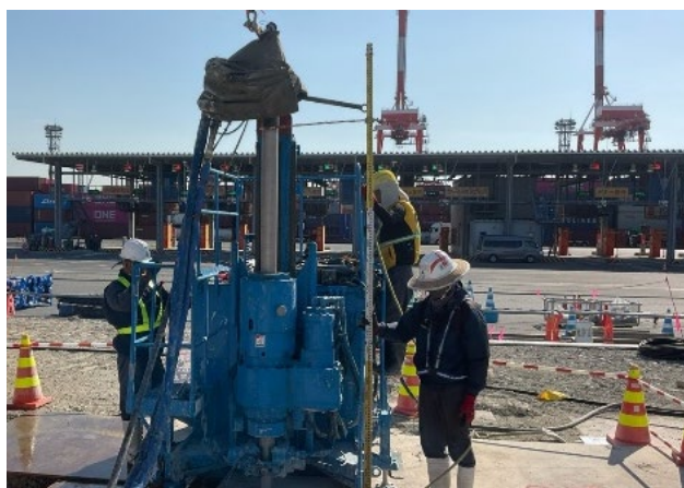
写真-4 高圧噴射攪拌による施工
