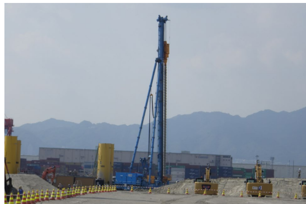
写真-3 機械攪拌による施工
