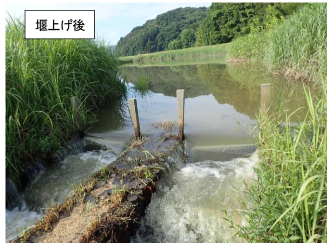
図-3 閉鎖型湿地の堰上げ状況
