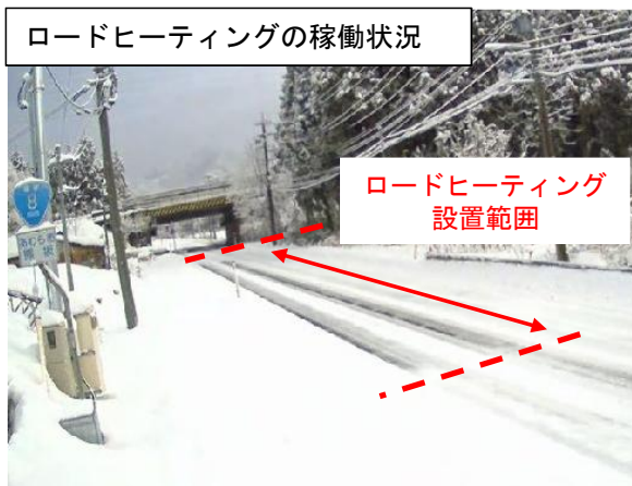
図-7 ロードヒーティングの稼働状況
