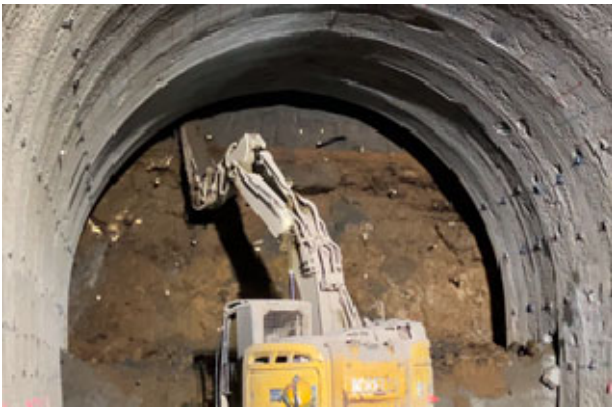
写真4 機械掘削状況
