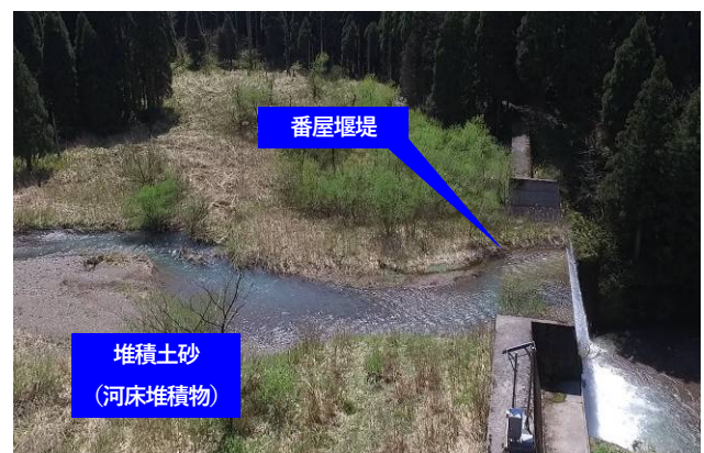
写真-1 番屋堰堤（既存）
