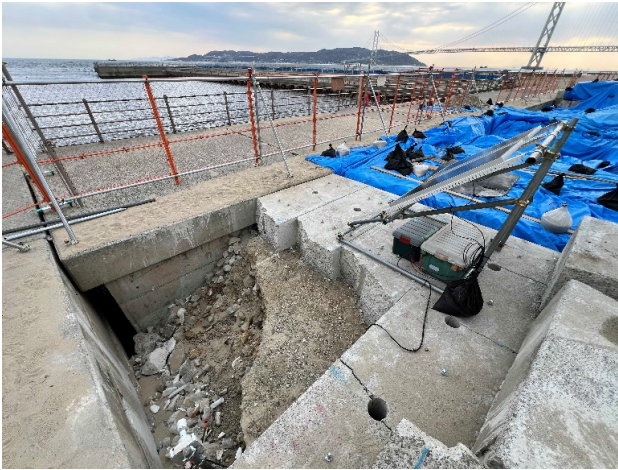
写真-1 空洞確認箇所の開削状況
