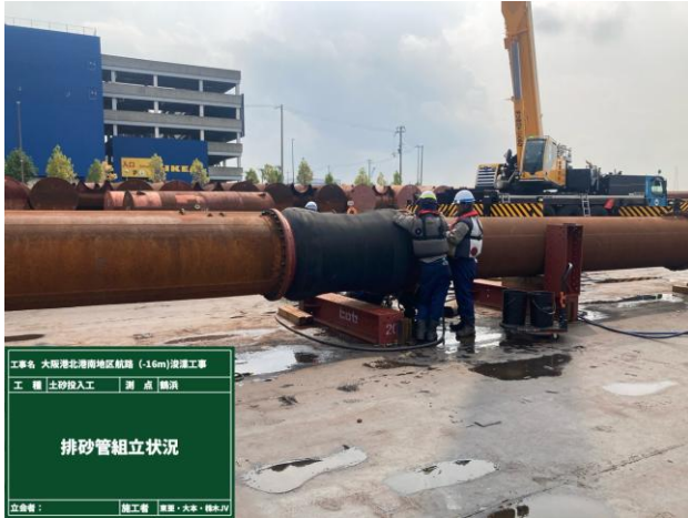
写真-3 排砂管組立の様子
