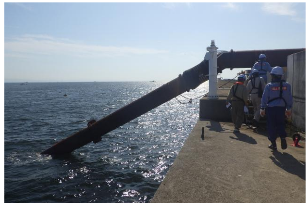
写真-2 立ち上がり零号の様子
