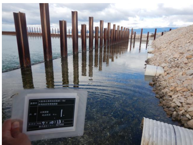
写真-8 余水吐での施工中現地調査の様子
