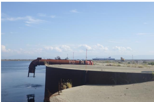
写真-7 土砂投入口の様子
