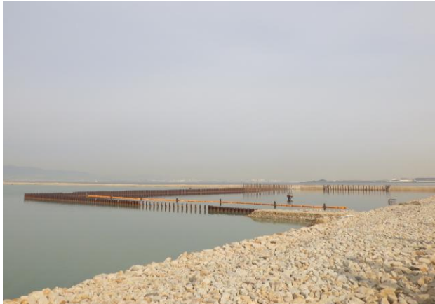
写真-6 新島内の沈殿池
