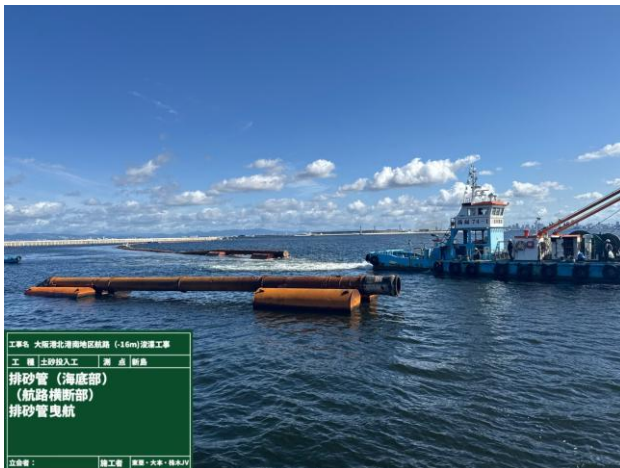
写真-4 排砂管曳航の様子
