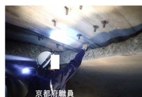
図-23 防水シート押上げ
