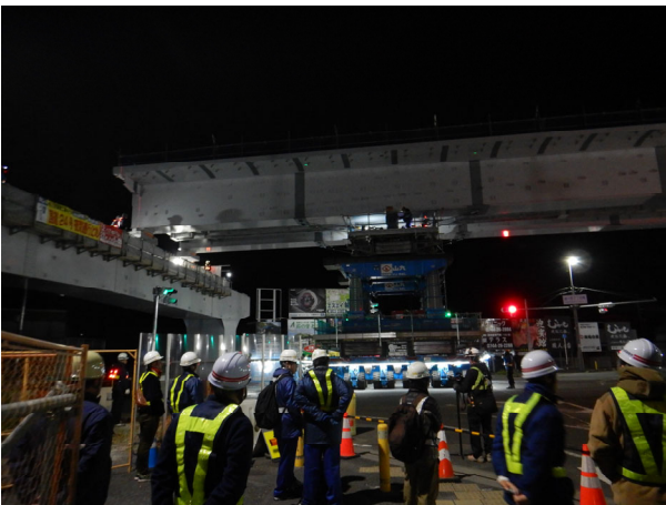
図-14 多軸式特殊台車を用いた架設
