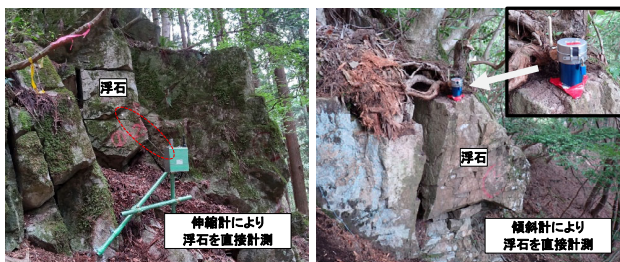
図-12 変位計によるモニタリング状況
