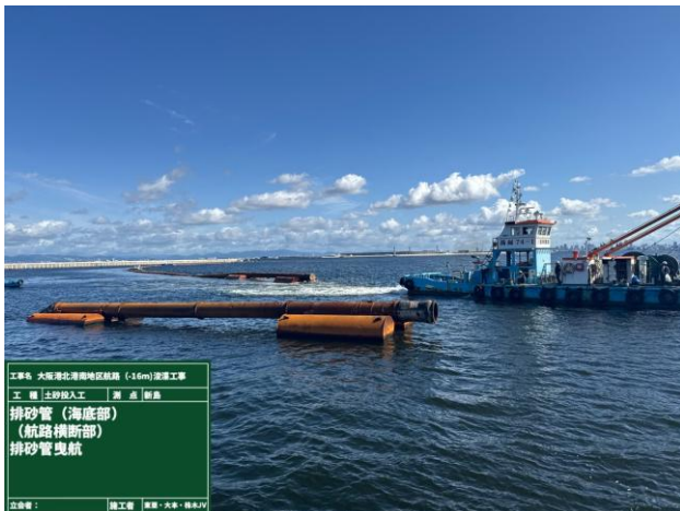
写真-4 排砂管曳航の様子
