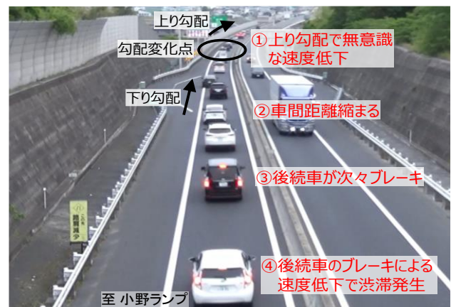
図-5 渋滞対策前のビデオ撮影結果(サグでの速度低下)
