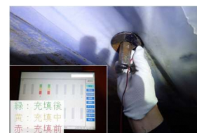
図-26 充填確認状況
