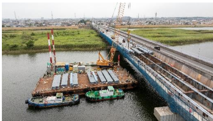
図-9 クレーン付き台船使用状況
