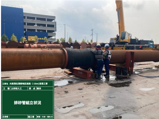
写真-3 排砂管組立の様子
