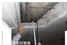
図-22 はつり落とし工
