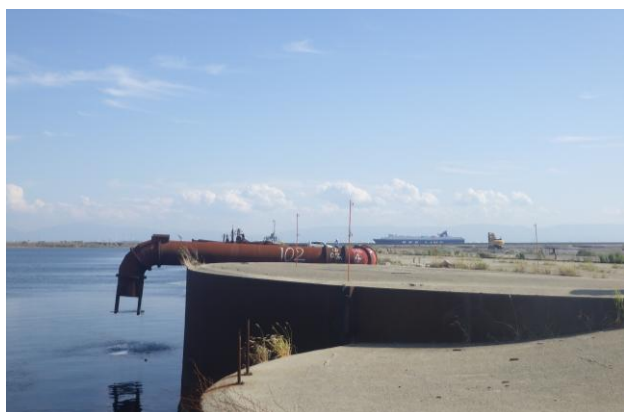
写真-7 土砂投入口の様子
