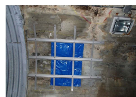
図-12 他トンネル事例
