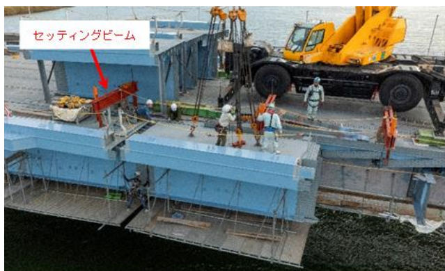
図-10 架設状況写真
