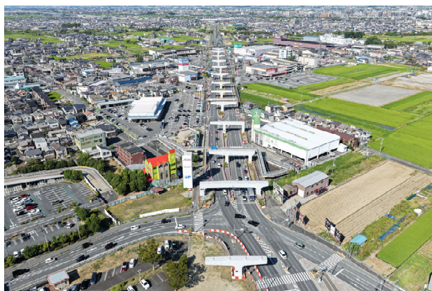
図-1 曲川町7丁目南交差点の上空写真
