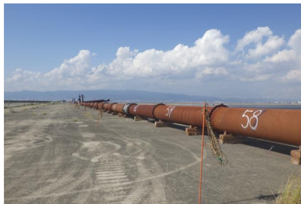
写真-1 陸上管の様子
