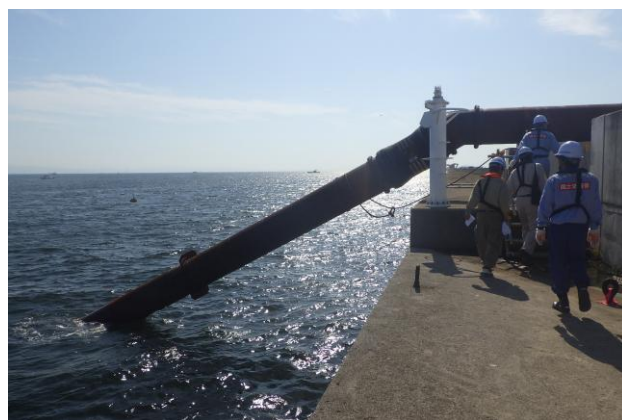
写真-2 立ち上がり零号の様子
