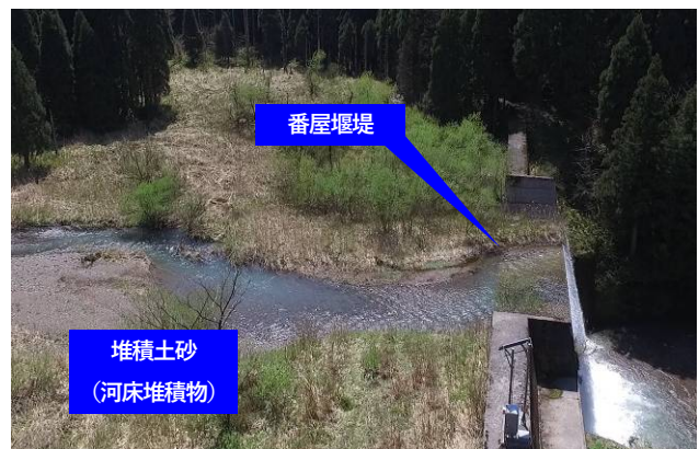
写真-1 番屋堰堤（既存）
