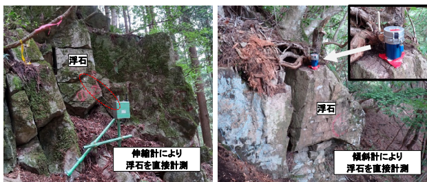
図-12 変位計によるモニタリング状況
