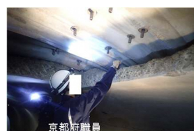
図-23 防水シート押上げ
