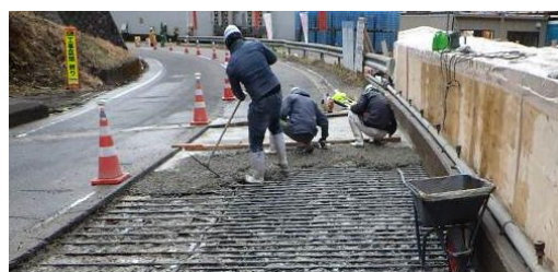
写真-10 N橋の床版断面修復工（床版上面）の様子
