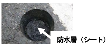
写真-3 I橋の舗装コア採取による床版防水層の有無確認
