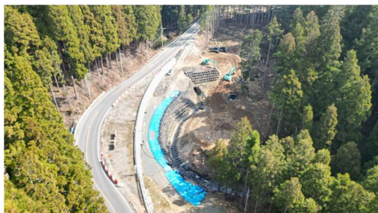
図4 ドローンによる現場写真
