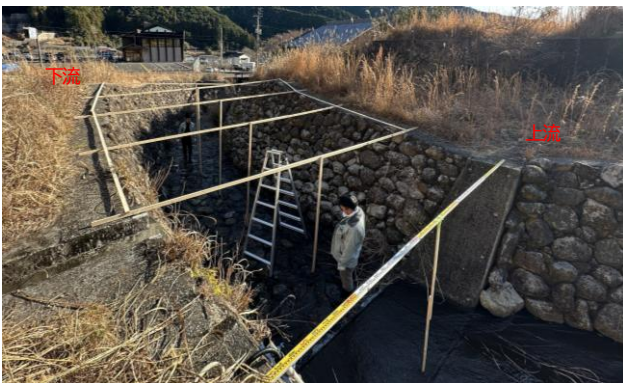
図-1 疑似堆砂モデルの設置状況
