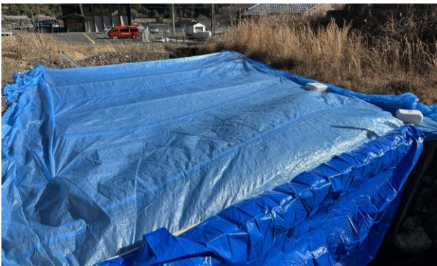
図-2 疑似堆砂モデル完成状況
