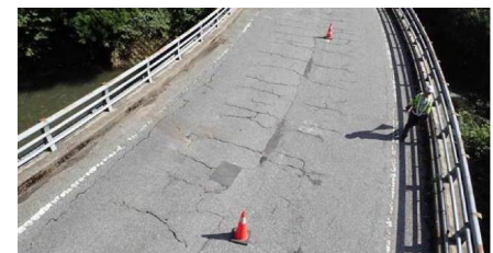
写真-6 N橋の路面状況
