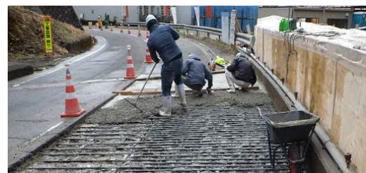
写真-10 N橋の床版断面修復工（床版上面）の様子
