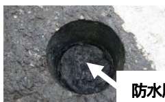
写真-3 I橋の舗装コア採取による床版防水層の有無確認
