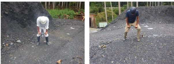
図-13 降雨後の盛土強度確認の写真
