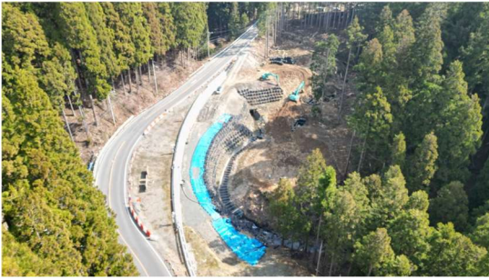
図4 ドローンによる現場写真
