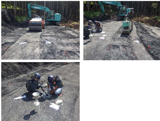
図-10 試験盛土および確認の状況写真
