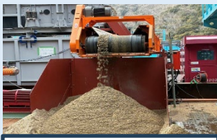
堆積土砂の浚渫
