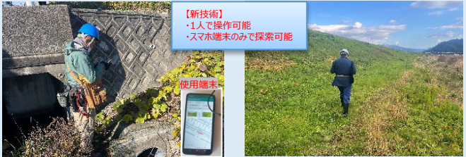
新技術による杭探索状況
