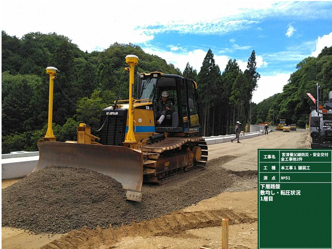
ICT建設機械MCブルドーザ
