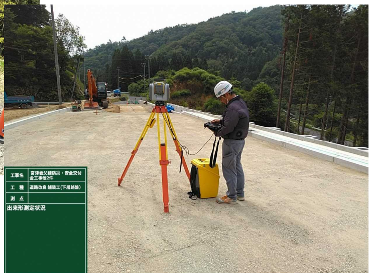
出来形計測（レーザースキャナー）
