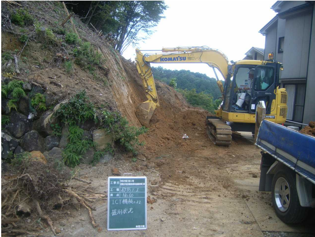
ICT建設機械MCバックホウ
