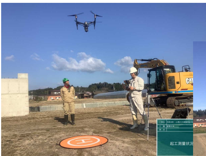
起工測量（空中写真測量）
