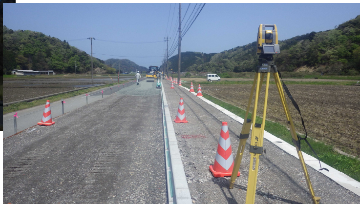
出来形計測 (レーザースキャナ)
