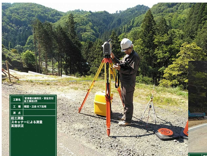
起工測量（レーザースキャナー）
