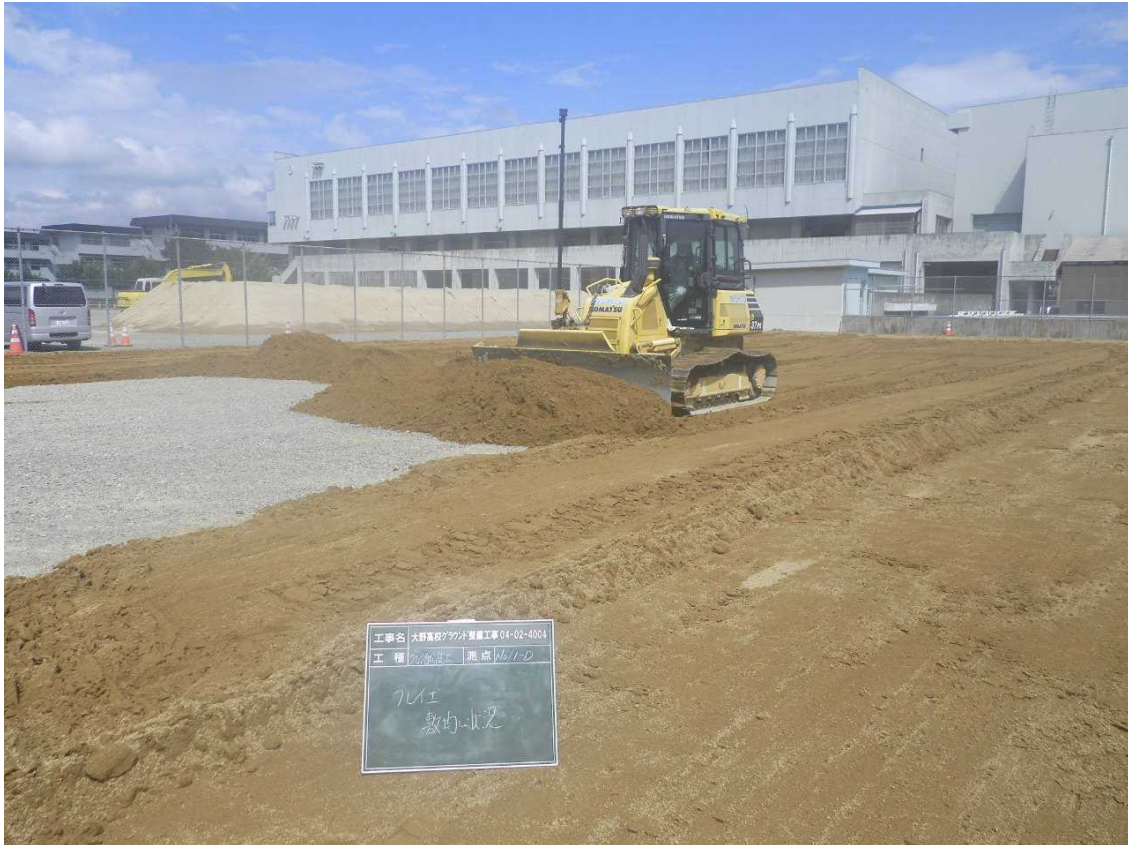
ICT建設機械3次元MCブルドーザー
