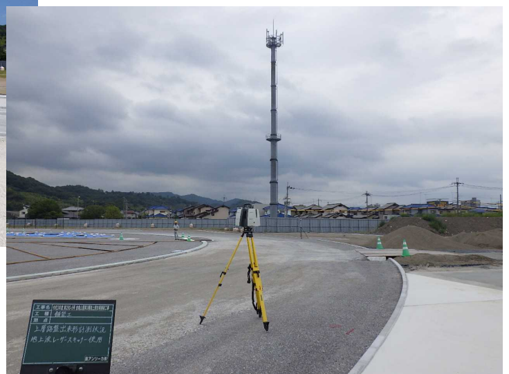
出来形計測（レーザースキャナー）
