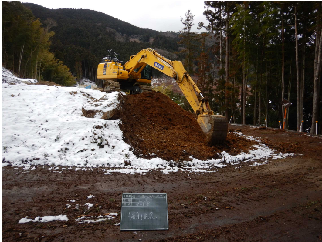
ICT建設機械 3次元MCバックホウ
