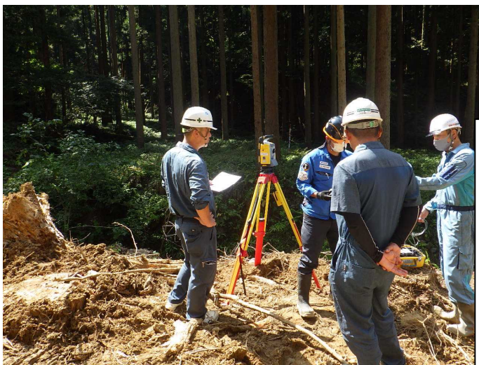
起工測量（レーザースキャナー）
