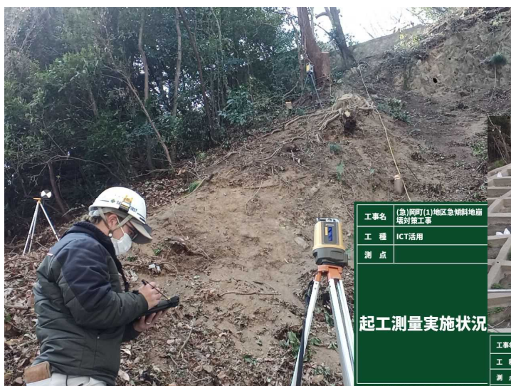
起工測量 (レーザースキャナー)
