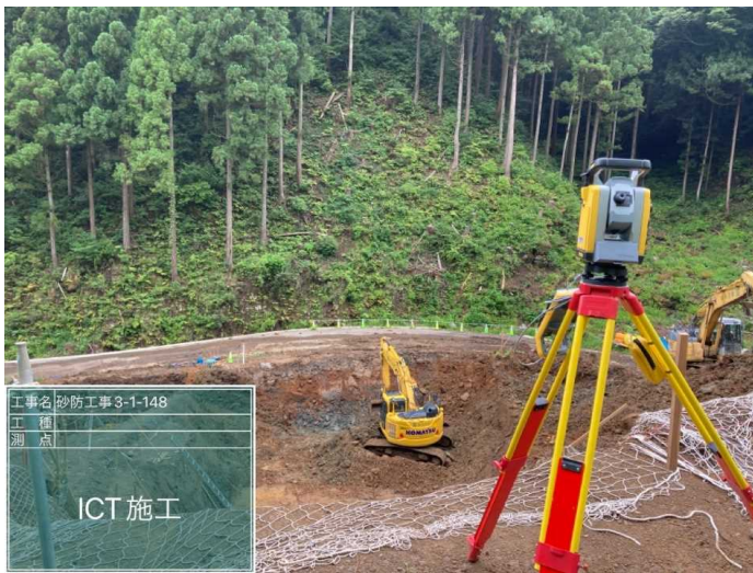
起工測量（レーザースキャナー）
