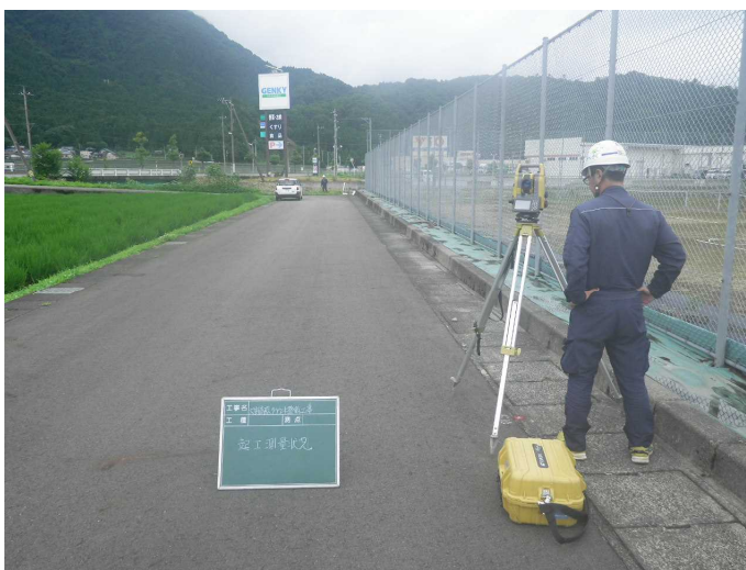
起工測量 (地上波レーザースキャナー)
