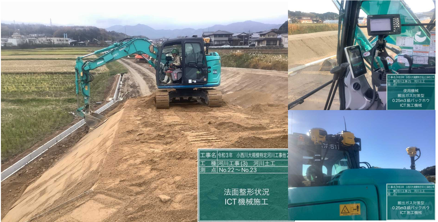
ICT建設機械 3次元MCバックホウ
