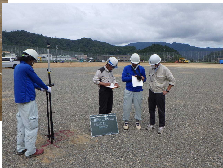
出来形計測（TS）
