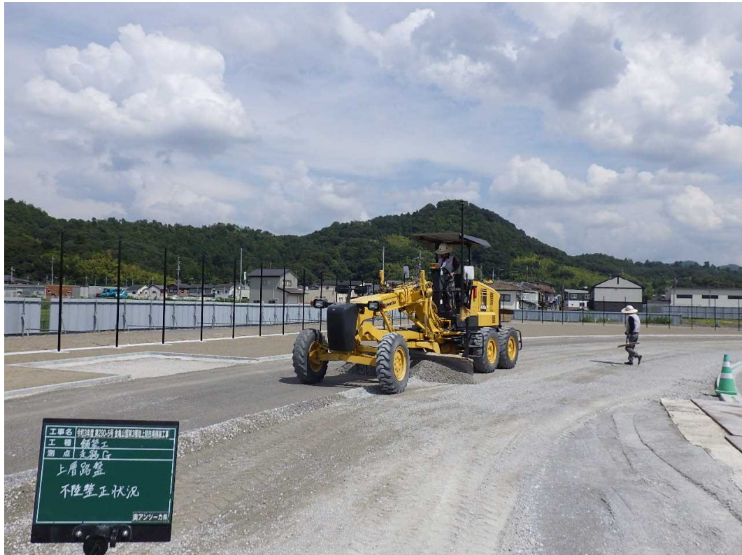
ICT建設機械3次元MCモーターグレーダー
