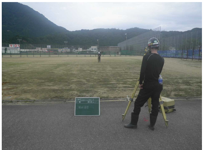
出来形計測 (TS)
