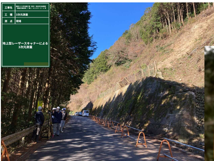
起工測量 (レーザースキャナー)
