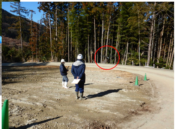
出来形計測 (空中写真測量)
