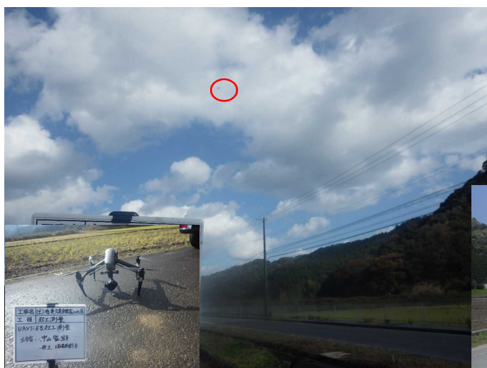
起工測量 (UAV)
