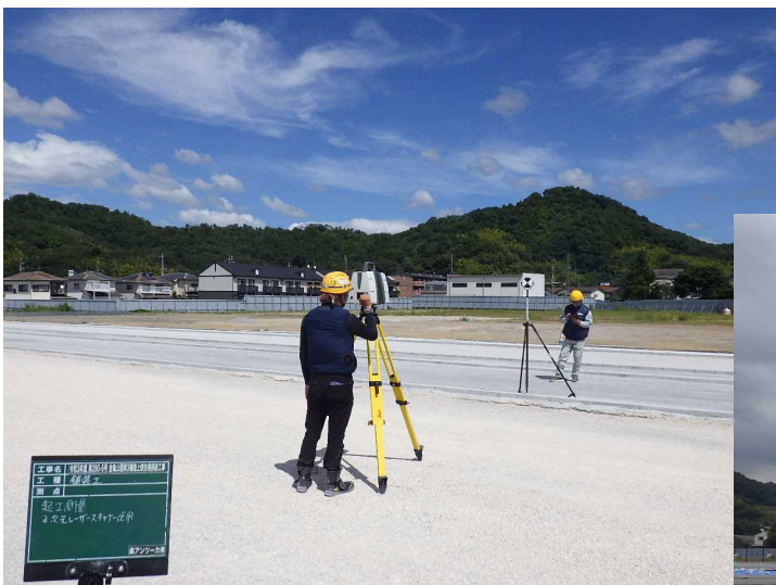
起工測量（レーザースキャナー）
