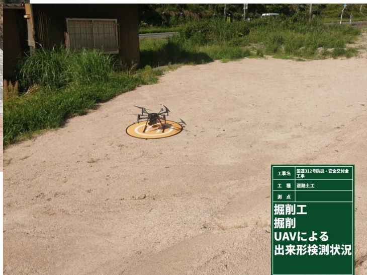
出来形計測（UAV）
