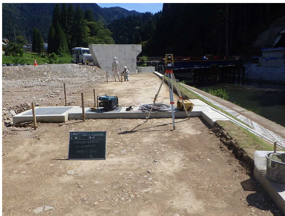
出来形計測 (TS)
