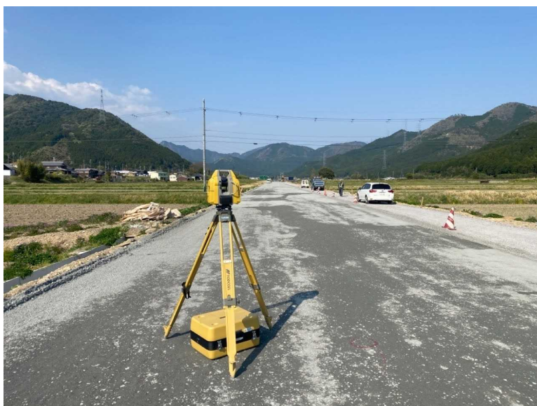
出来形計測（レーザースキャナー）
