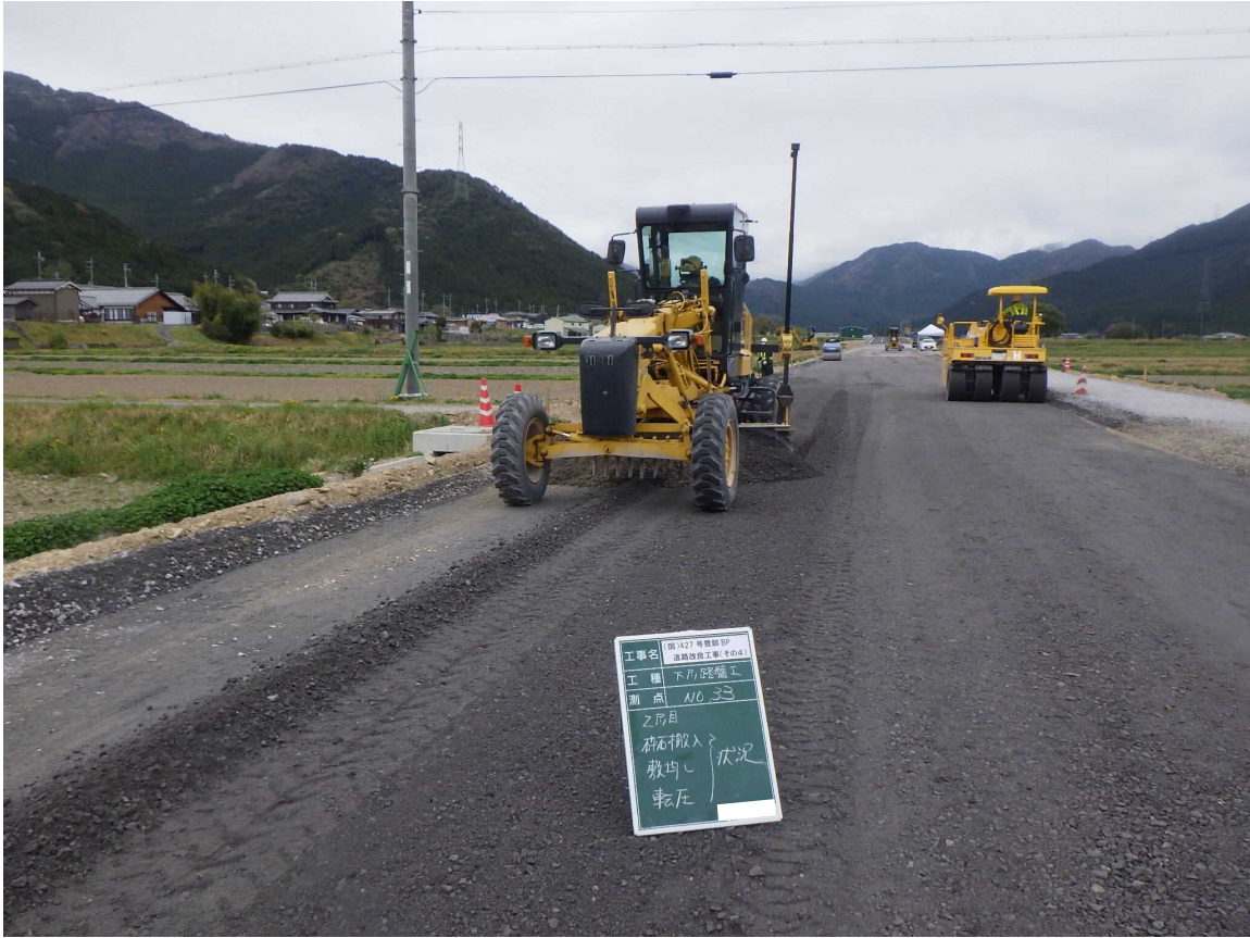
ICT建設機械MCモーターグレーダ
