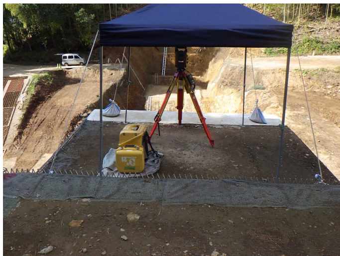
出来形計測 (レーザースキャナー)
