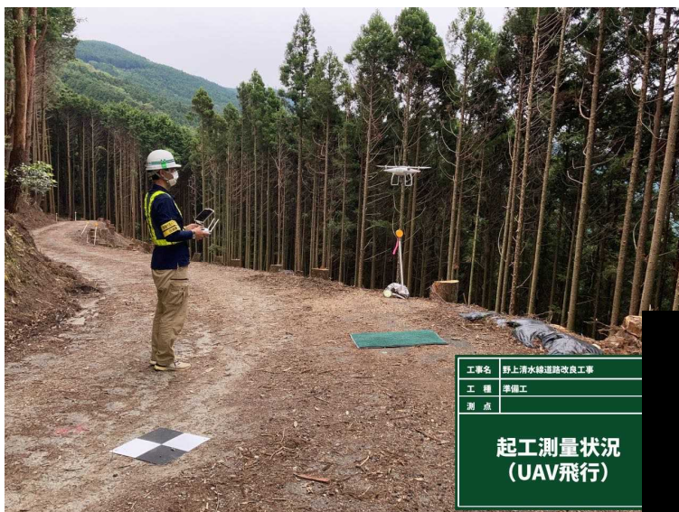
起工測量（空中写真測量 UAV）
