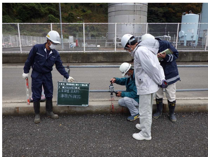
出来形計測 (TS)
