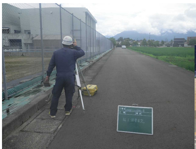
起工計測 (地上レーザースキャナー)
