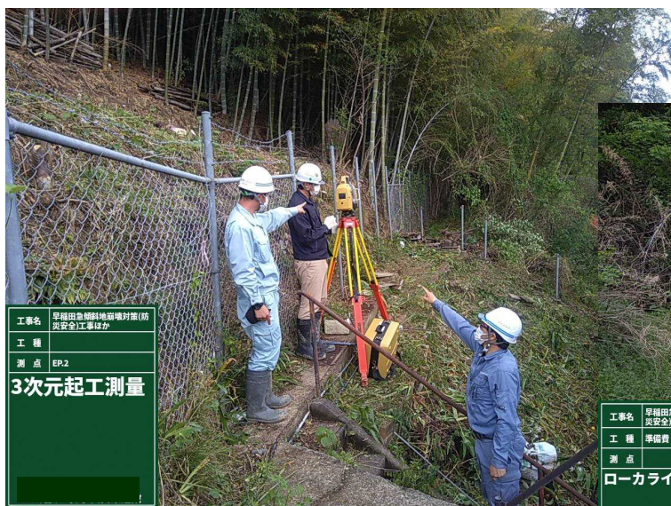
起工測量（レーザースキャナー）
