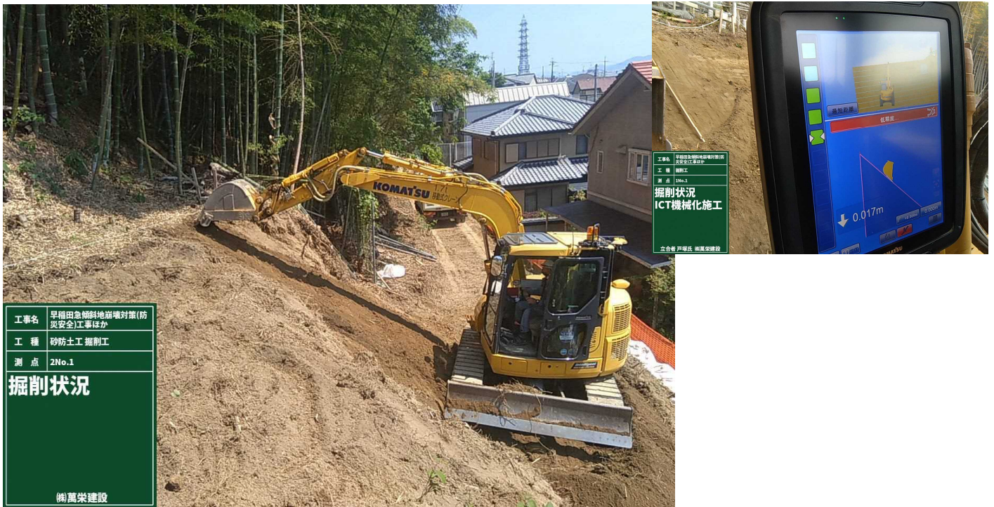
ICT建設機械 3次元MCバックホウ
