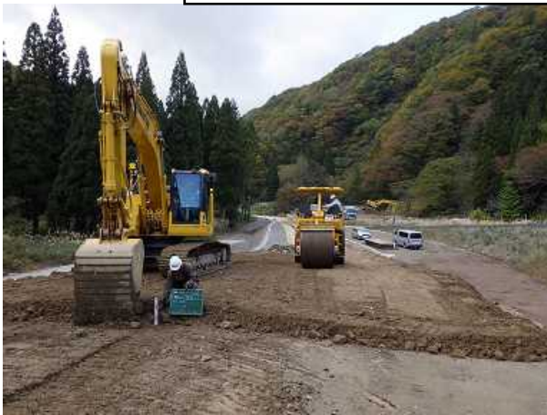
盛土工巻出し
