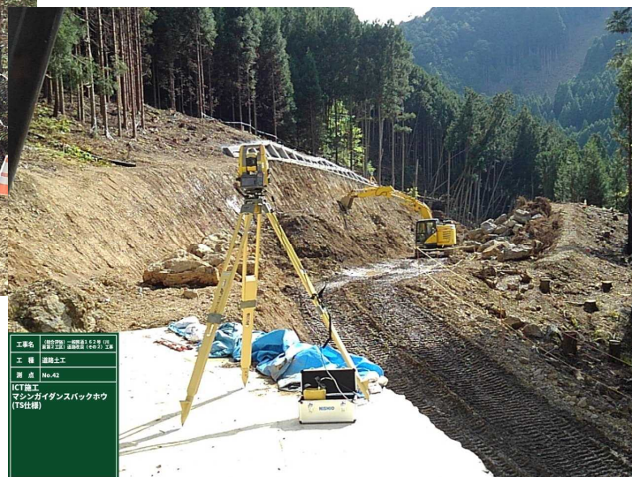
出来形計測（TS）
