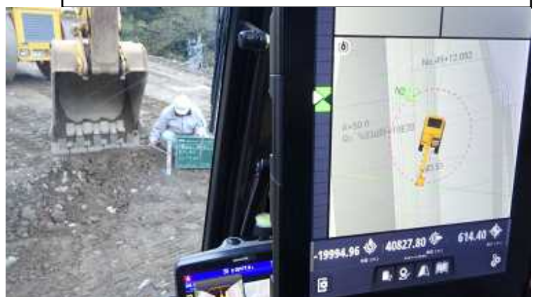
ICT建機 敷均し高さ確認
