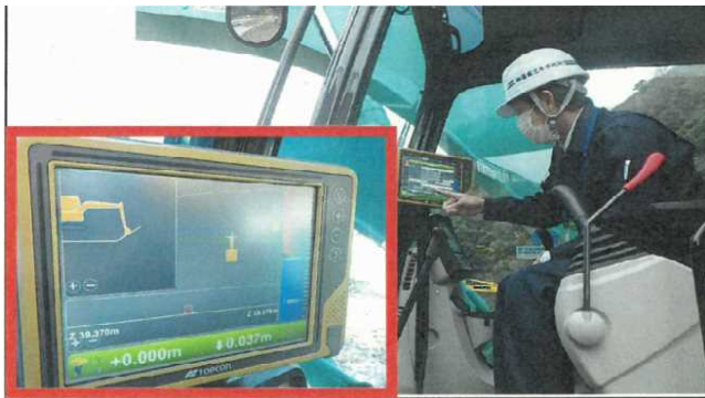
土砂掘削 3次元設計データの作成
