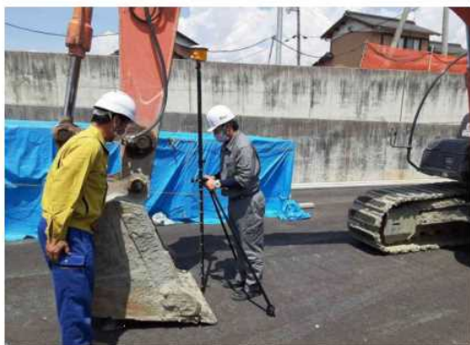
ICT建機 (バックホウバケット刃先精度確認)
