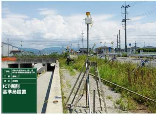
西側GNSS基準局設置
