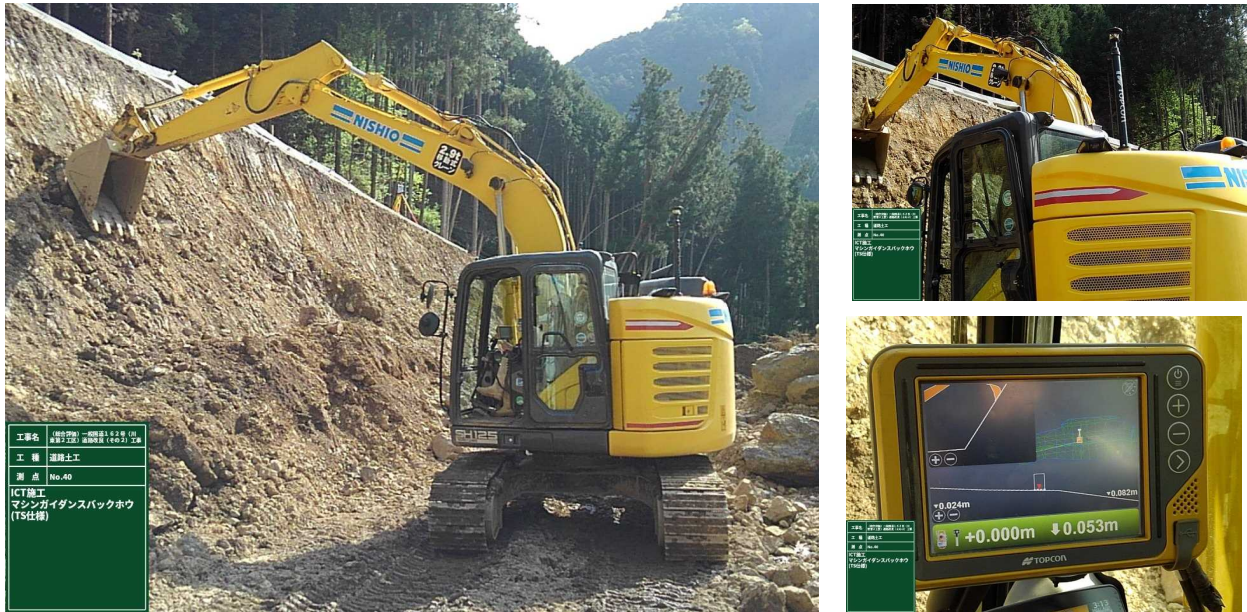
ICT建設機械3次元MGバックホウ
