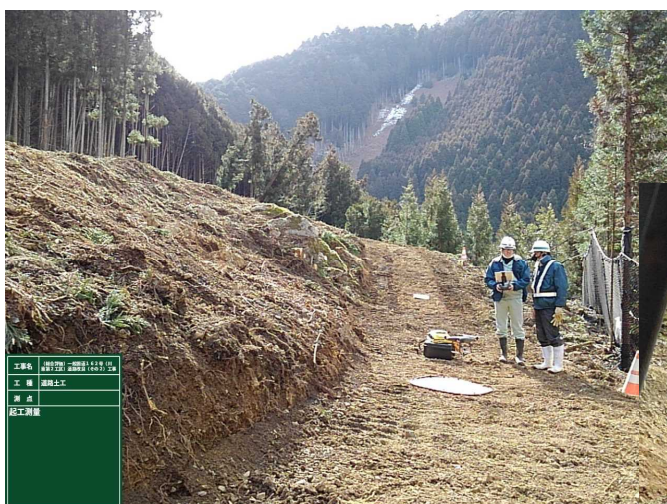
起工測量（無人航空機）
