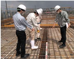
（従来）マーキング、メジャーの設置
