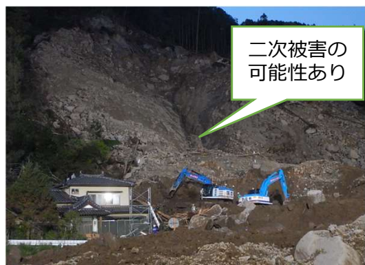
土砂崩落地による災害復旧作業
