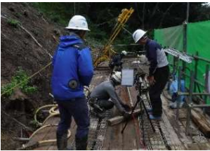
現場撮影状況
