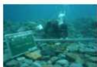
基礎捨石投入における潜水作業
