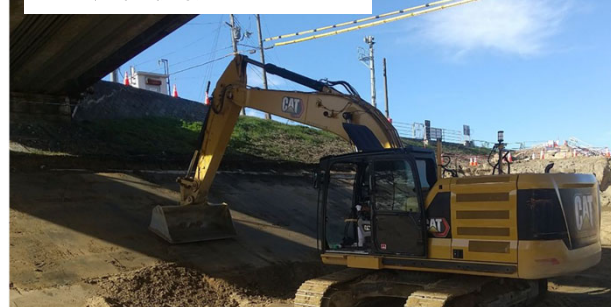
ICT建設機械による施工
