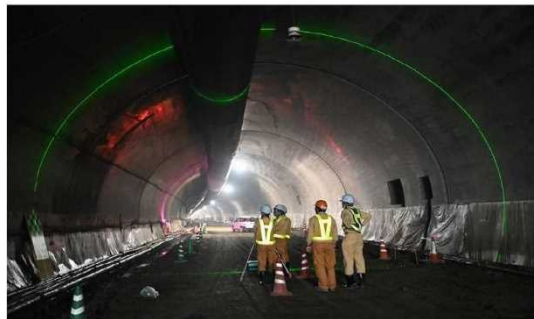
トンネル覆工面にリングレーザーを照射した状況
