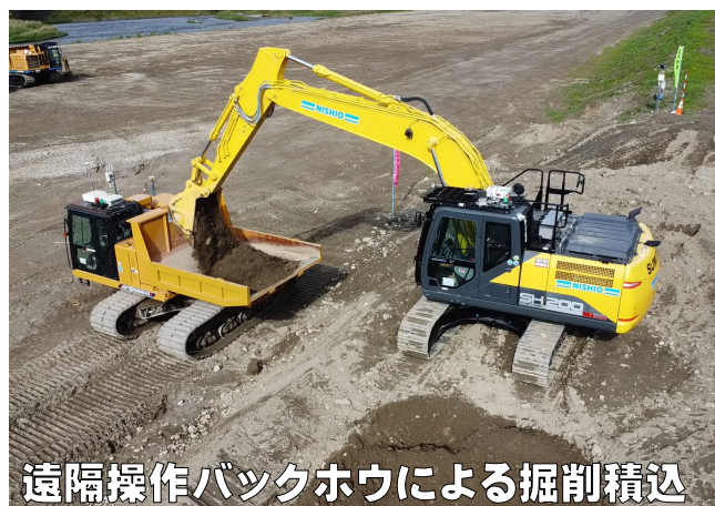
自動走行不整地運搬車による運搬
