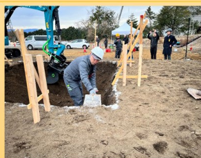
端部はスコップを用いて人力作業
