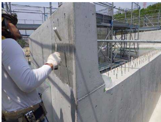
高欄部 塗布状況
