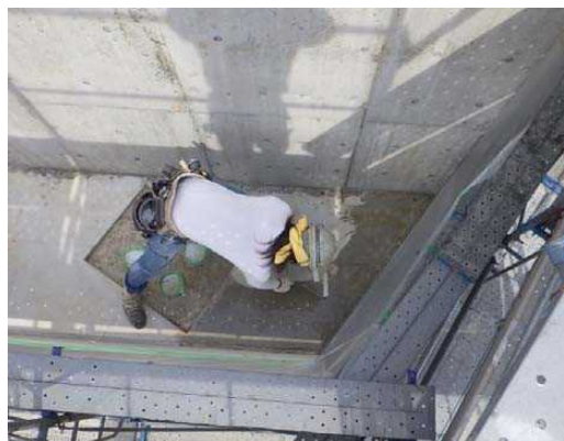
橋座部 塗布状況
