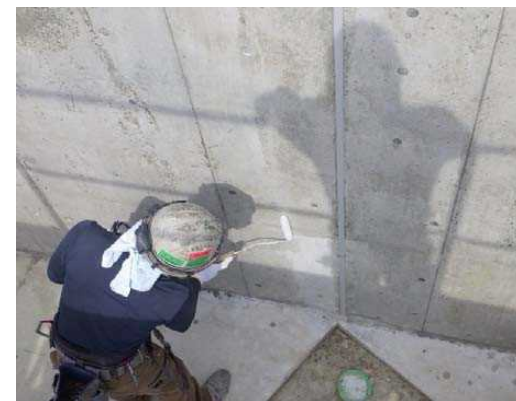
胸壁部 塗布状況
