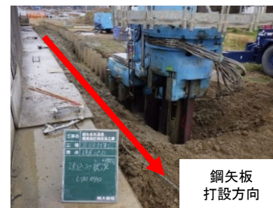
鋼矢板打設状況 (アースオーガ併用圧入工法)
