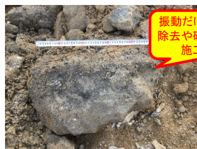
硬質な地盤（玉石）の発生状況
