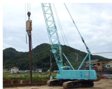
鋼矢板打設状況 (バイブロハンマー工法)
