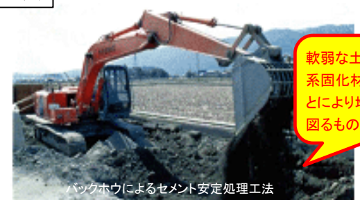
改良工法 <セメント安定処理工法による軟弱地盤対策>
