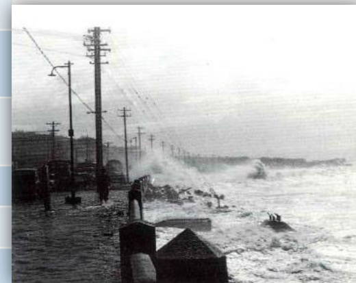
高潮被害(狩口地区)昭和39年台風第20号
