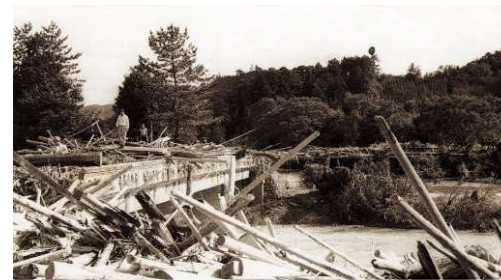
なつみ 名張市夏見地区の被災状況
