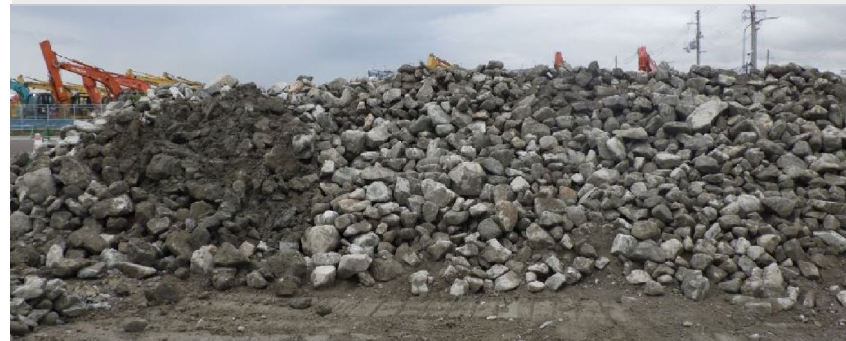
地中に含まれる礫、玉石(掘削除去の事例)
