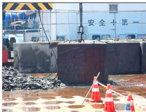
他事業の防波堤撤去工事で 発生する方塊ブロック
