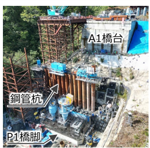
鋼管杭による抑止対策
