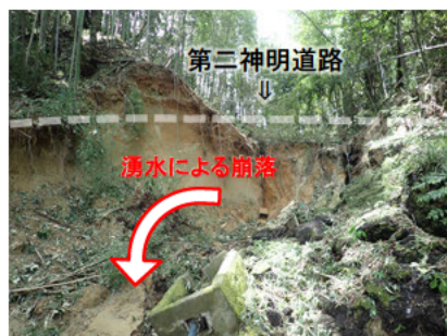
断層部における土砂崩落
