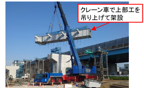
変更計画:トラッククレーン架設
