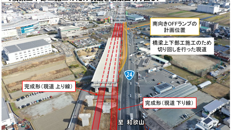
＜橋梁上下部工施工のため現道を複数回切り回し＞
