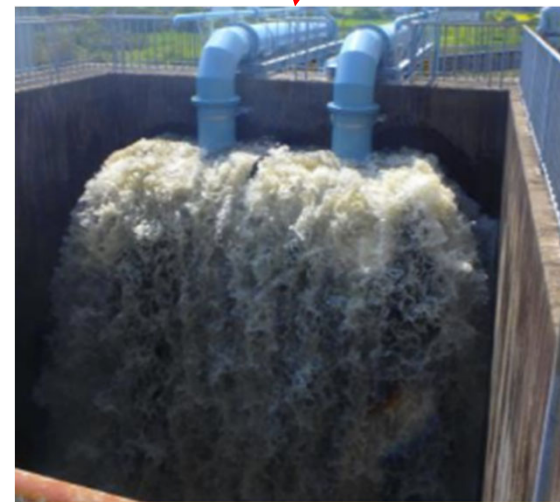
ポンプ試運転の様子 6
