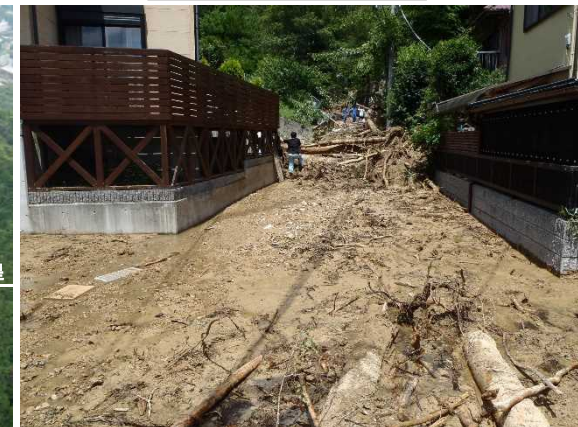
神戸市北区山田町上谷上字古々山: 約500m 3 の土砂が流出 (ダンプトラック100台分)
