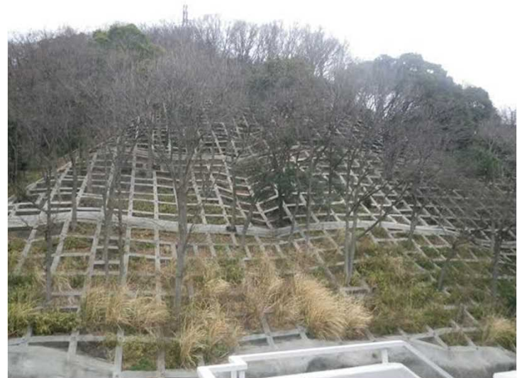
現存植生を保全した斜面对策工 高取中央地区(妙法寺川水系)
