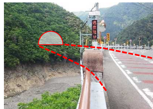
写真② 小休場橋付近(上り方向を望む) (撮影日: H28年5月20日(金))
