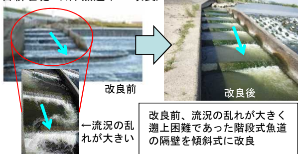
古新堰堤 右岸魚道 (H20改良)
