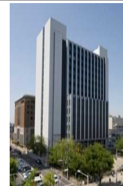
堺地方合同庁舎の整備状況
