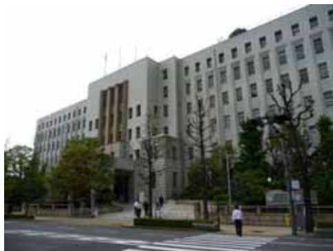
大阪府庁舎(1926完成)
