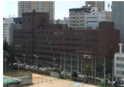
大阪第2法務総合庁舎(1977完成)
