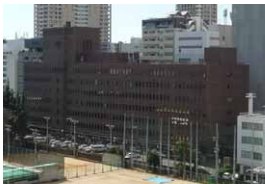
大阪第2法務総合庁舎(1977完成)
