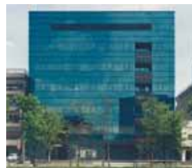
天王寺法務総合庁舎(1990完成)
