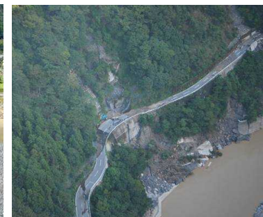
写真② 道路崩壊箇所 (撮影時期: H23年紀伊半島大水害直後)
