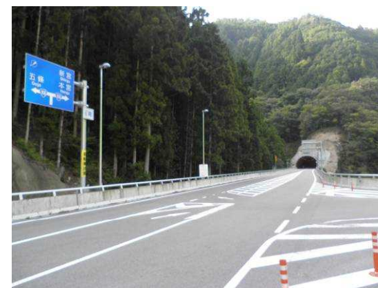
写真① 今戸トンネル(滝出入口側) (撮影日: H25年9月24日(火))
