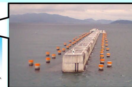
鋼板セル型防波堤
