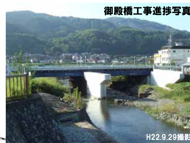
御殿橋工事進捗写真 H22.9.29撮影 ← : 写真撮影方向
