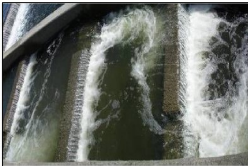
はくりりゅう 剥離流や気泡により魚類の遡上に適さない。 こしんえんてい 古新堰堤右岸魚道 (改修前 H14.3)
