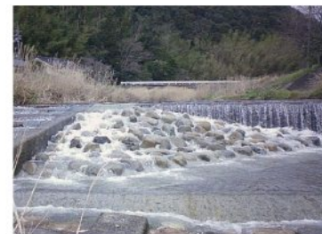
きめ細かな工夫による魚道整備例 (山口県 小わざ魚道)
