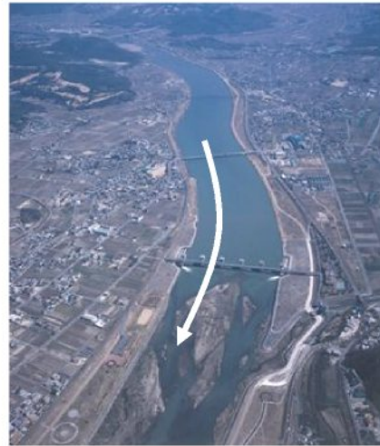
加古川大堰上部湛水および下流部砂州の発達状況 (H20. 3)
