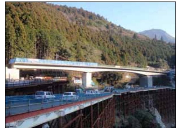
②今戸高架橋上部工事 平成23年2月末撮影
