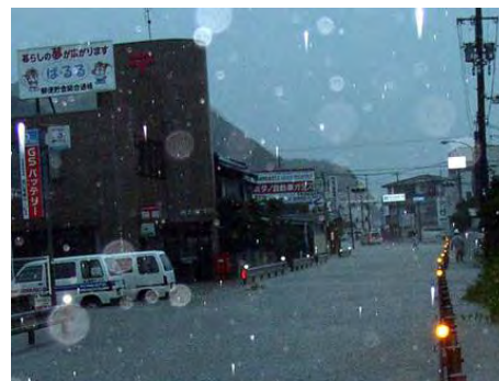
現道の冠水状況 (写真②)
