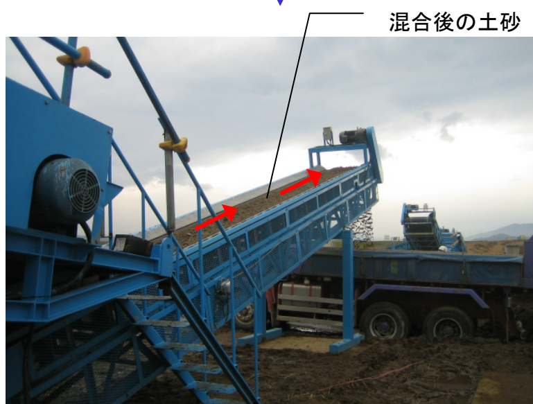
混合後の土砂をトラックに積込
