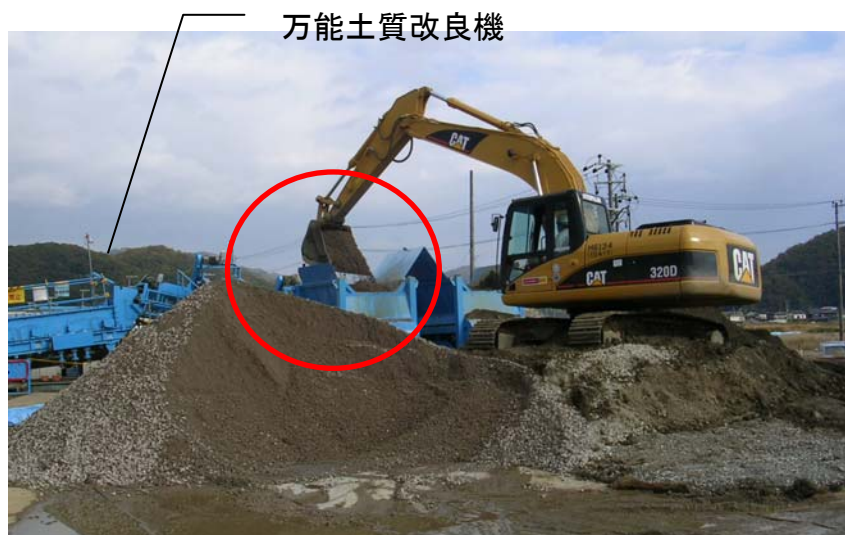
材料となる土砂を改良機に投入
